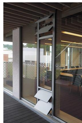
上下に手動の換気窓がある縦長スリットによる開口。
