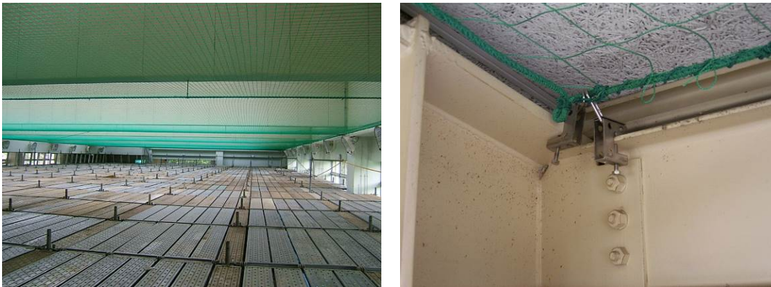
写真-2 基準施工以前のネットによる落下防止措置
