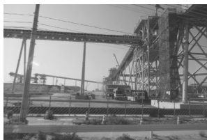
縦横に構築された巨大な構造物
