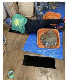
令和4年台風第15号災害時の作業（磐田市）
