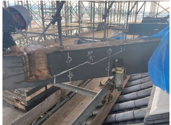
工事中 隅扱首継手仮墨付
