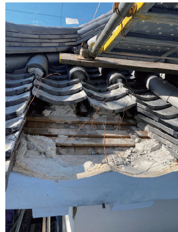
工事中 上重屋根破風尻 瓦取外し
