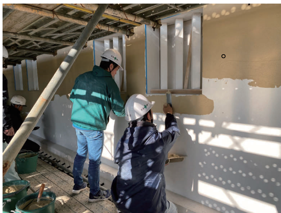
工事中 土佐漆喰上塗り
