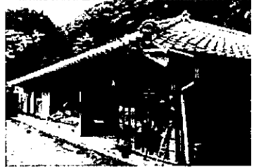
④二俣公会堂 (旧伊久美銀行) 明治10年初期建設
