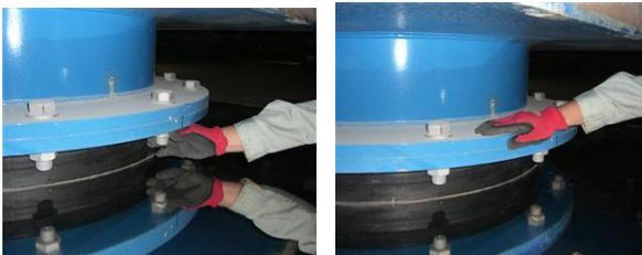
写真 8 ボルトに緩みはないか 写真 9 鋼材部に錆・塗膜剥離はないか
