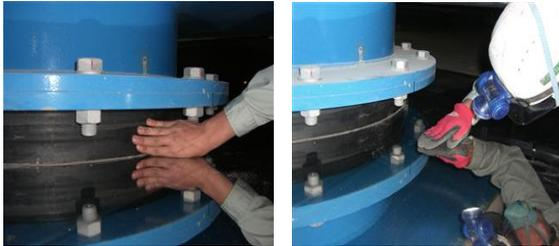
写真 6 ゴムに劣化・損傷はないか 写真 7 すべり面に損傷・異物はないか
