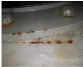
写真 3 鋼材部の特にボルトに錆発生している。
