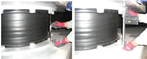
写真 4 鉛直変位に変化はないか 写真 5 水平変位に変化はないか
