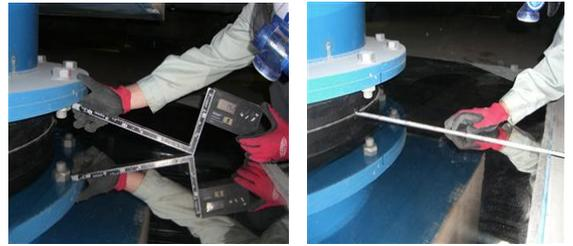
写真 10 鉛直変位に変化はないか 写真 11 水平変位に変化はないか
