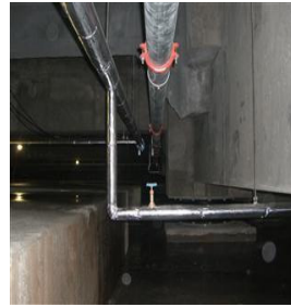
写真 21 配管に余裕度があるが 写真 22 可撓継手部に問題はないが
