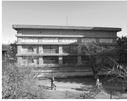
住吉浄水場ポンプ室
