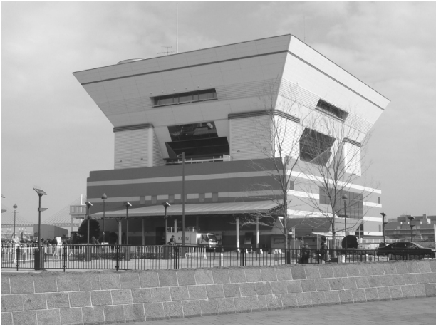
横浜大榎橋ふ頭ビル
