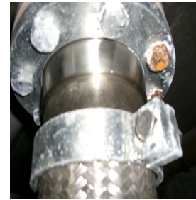
写真 21 配管に余裕度があるが 写真 22 可撓継手部に問題はないが
