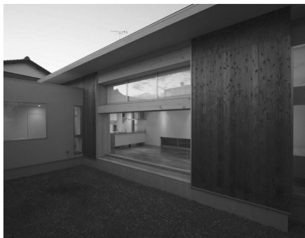
囲い庭より見る
