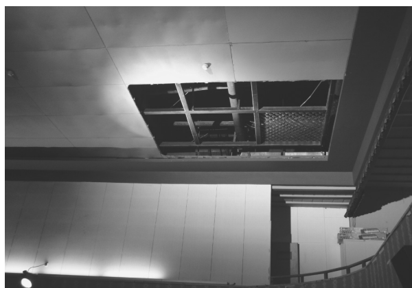
天井を剥がすと、芝居小屋当時の格子天井が現れる
