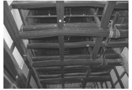
清水家住宅 土間上部小屋組み
