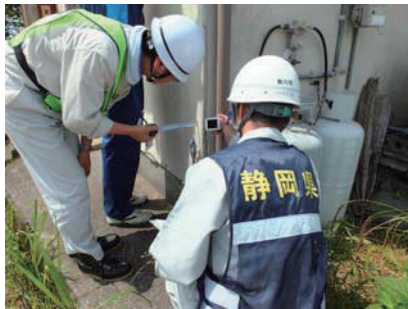
写真1 2次調査の様子① (建物傾斜測定)
