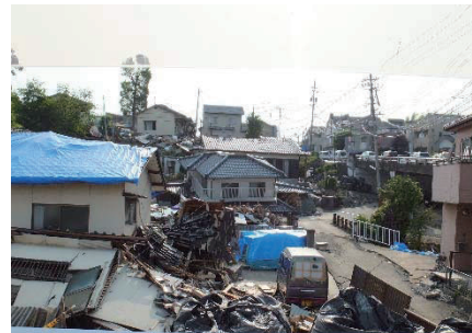
写真7 益城町の被害状況
