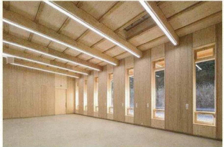
大断面のLVL構造体により実現した無柱空間
