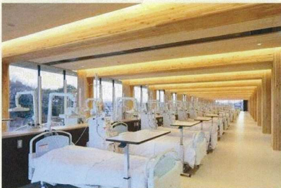
門型木フレームが連続する透析室
